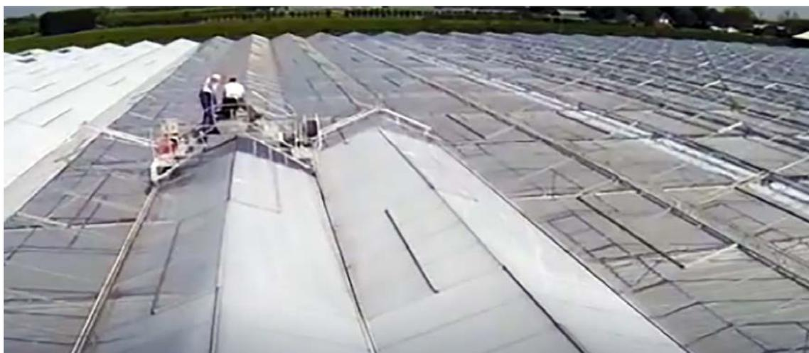
**Рисунок 1 – Процесс забеливания кровли теплиц**
