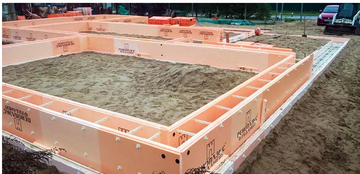
Рисунок 2 – Сборка несъемной опалубки
