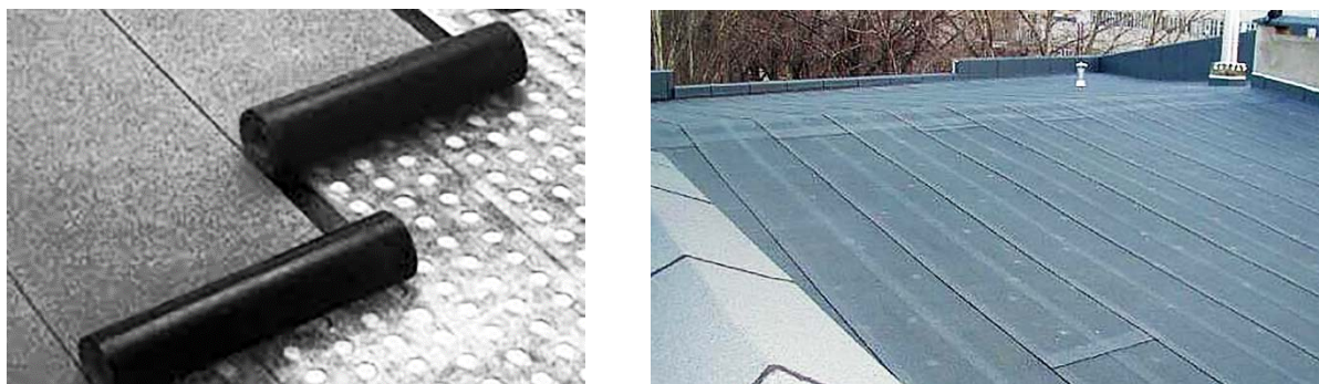
Рисунок 1 – Мягкая рулонная кровля
