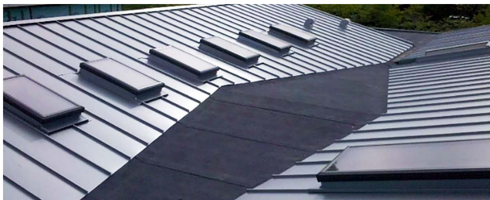
Рисунок 2 – Кровля из металлочерепицы
