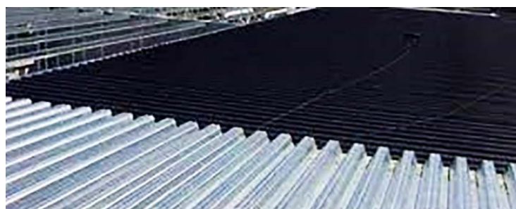
Рисунок 3 – Кровля из профнастила
