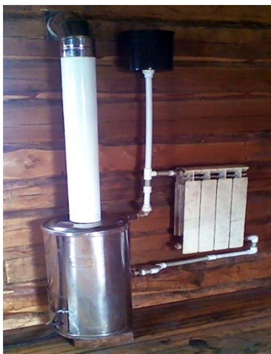
Рисунок 2 – Экспериментальная система отопления
