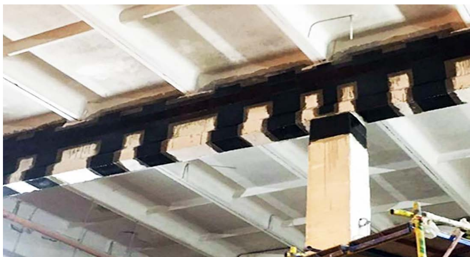
Рисунок 3 – Усиление балок и ригелей
