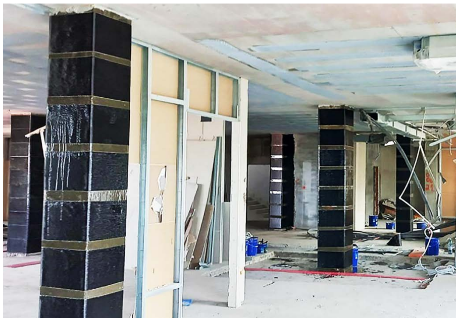
Рисунок 2 – Внешнее армирование колонн
